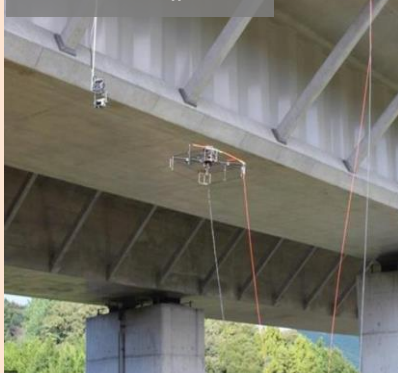
▼高速道路橋梁
