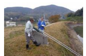
ため池の現地パトロール
