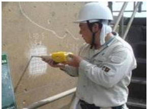
老朽化した施設の機能診断
