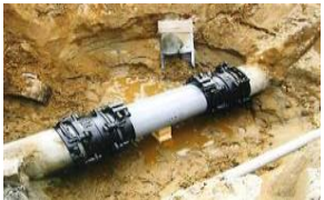
漏水防止のための整備
