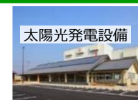
太陽光発電設備
