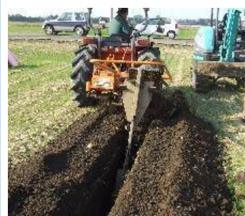
暗渠排水の整備
