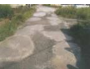
農道の窪みの補修
